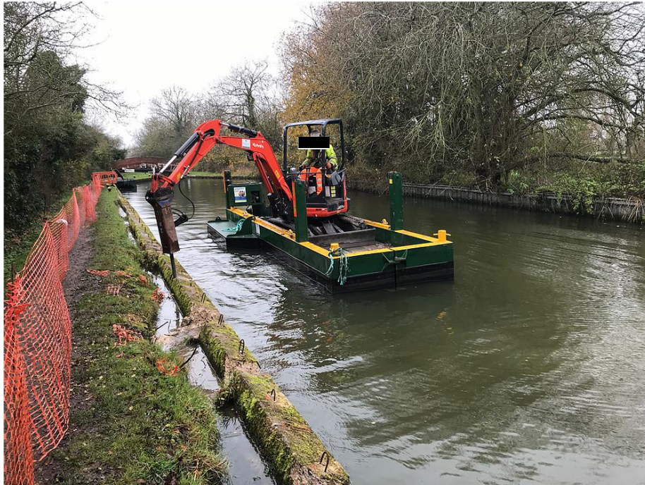
Figure 24 - Mini Excavator on Pontoon
